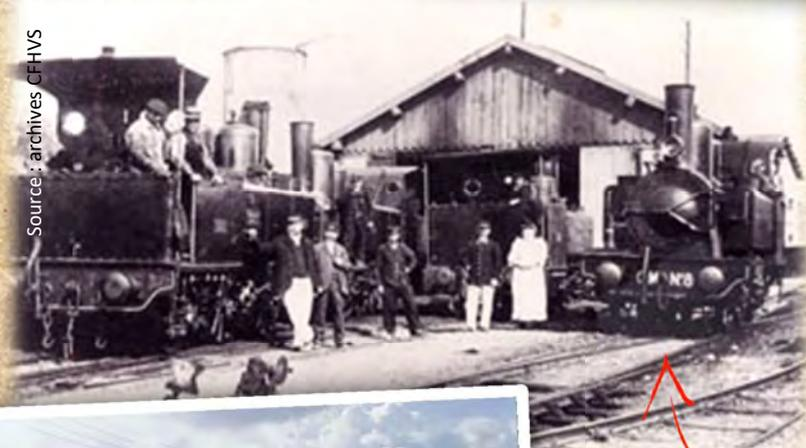
**Le dépôt des locomotives** se trouvait un peu plus en amont, le long du canal. On y trouvait le nécessaire pour réparer et bichonner les machines, notamment une réserve d'eau visible ici, à gauche du dépôt.
